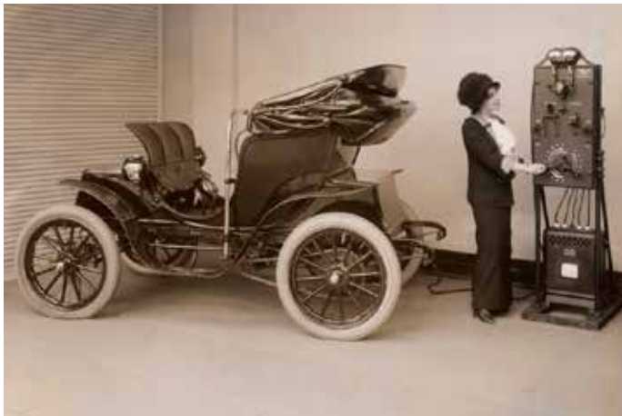
Um 1912 benutzt eine junge Frau ein per Hand zu bedienendes Ladegerät für die Batterien ihres Elektroautos, Modell Columbia Mark 68 Victoria
