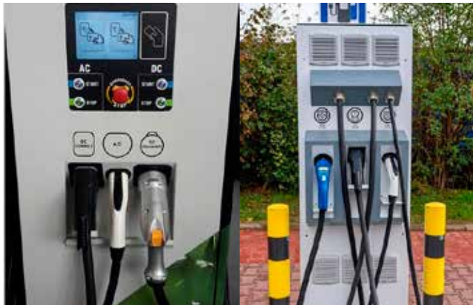
Ladesäulen mit Typ-2 (AC)-, CCS-Combo-2(DC) und CHAdeMO (DC)-Anschlüssen
