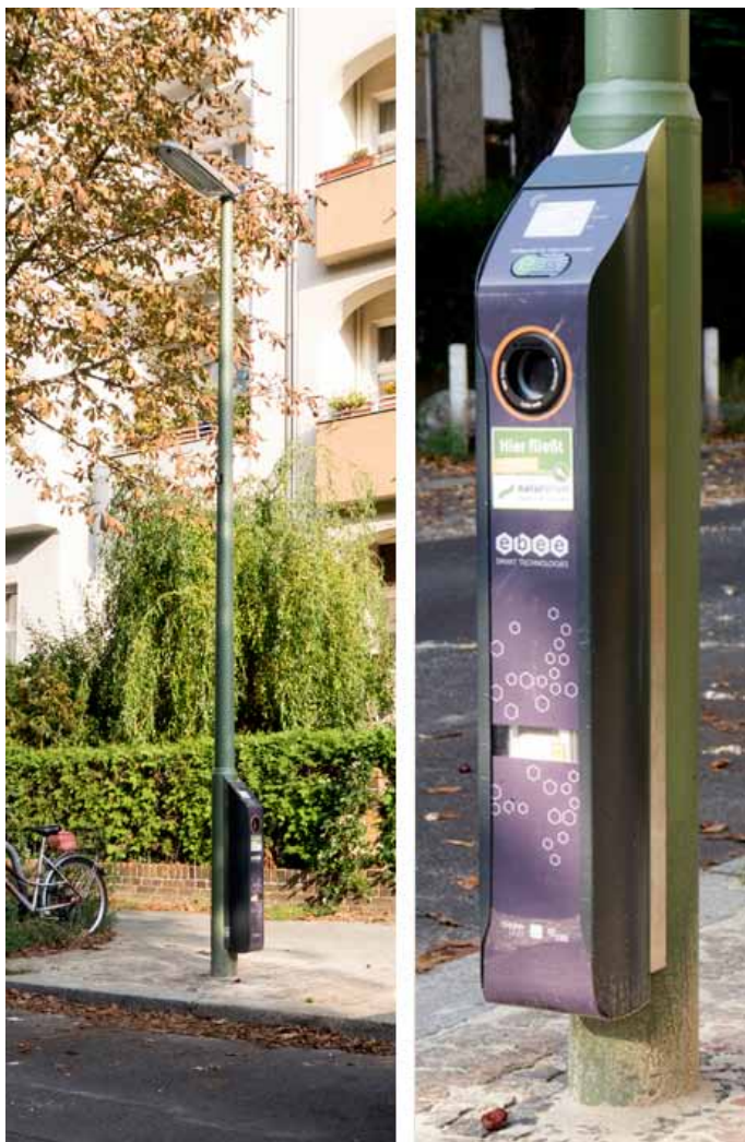
Abb.: Der Ladepunkt »Berlin« wurde speziell für die Kombination mit Leuchten konzipiert. (Quelle: Ebee)
